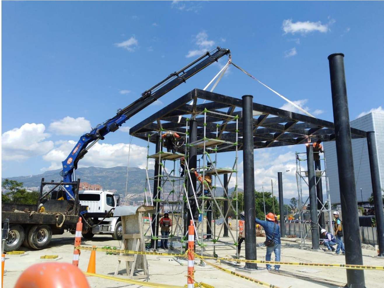
Estructura Metálica Pabellón Occidental Proyecto Parques del Rio – Alcaldía de Medellín
