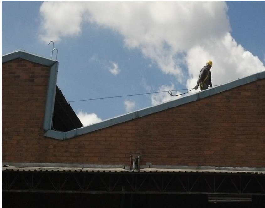
Línea de vida Horizontal externa en techos de SOFASA
