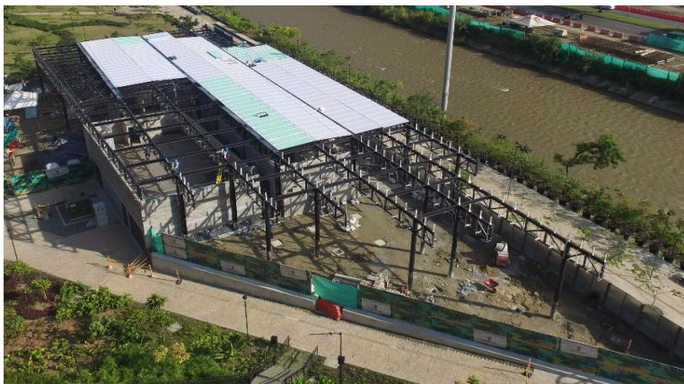
Estructura Metálica Pabellón Oriental Proyecto Parques del Rio – Alcaldía de Medellín
