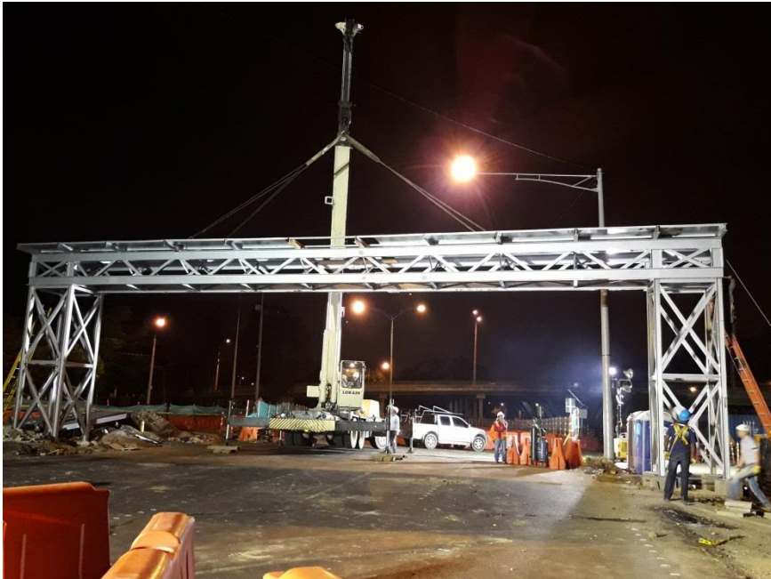
Puente Peatonal Metálico Parques del Rio Alcaldía de Medellín
