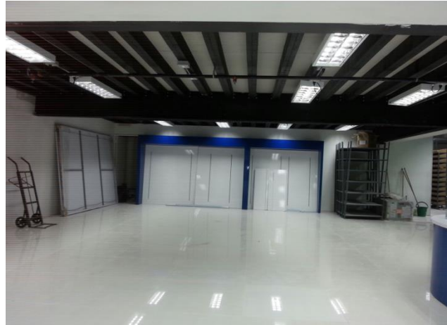
Mezanine Metálico Alkomprar-Mayorca
