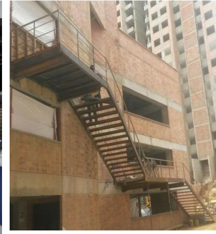
Escaleras de emergencia
