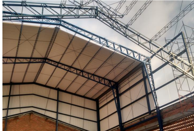
Estructura Metálica para Cubiertas Pegaicho
