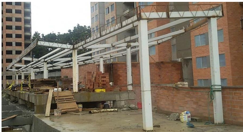
Cubierta metálica zona social Apartamentos Madera
