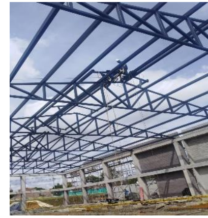
Cubierta metálica bodega EPM en Rionegro - GAIA
